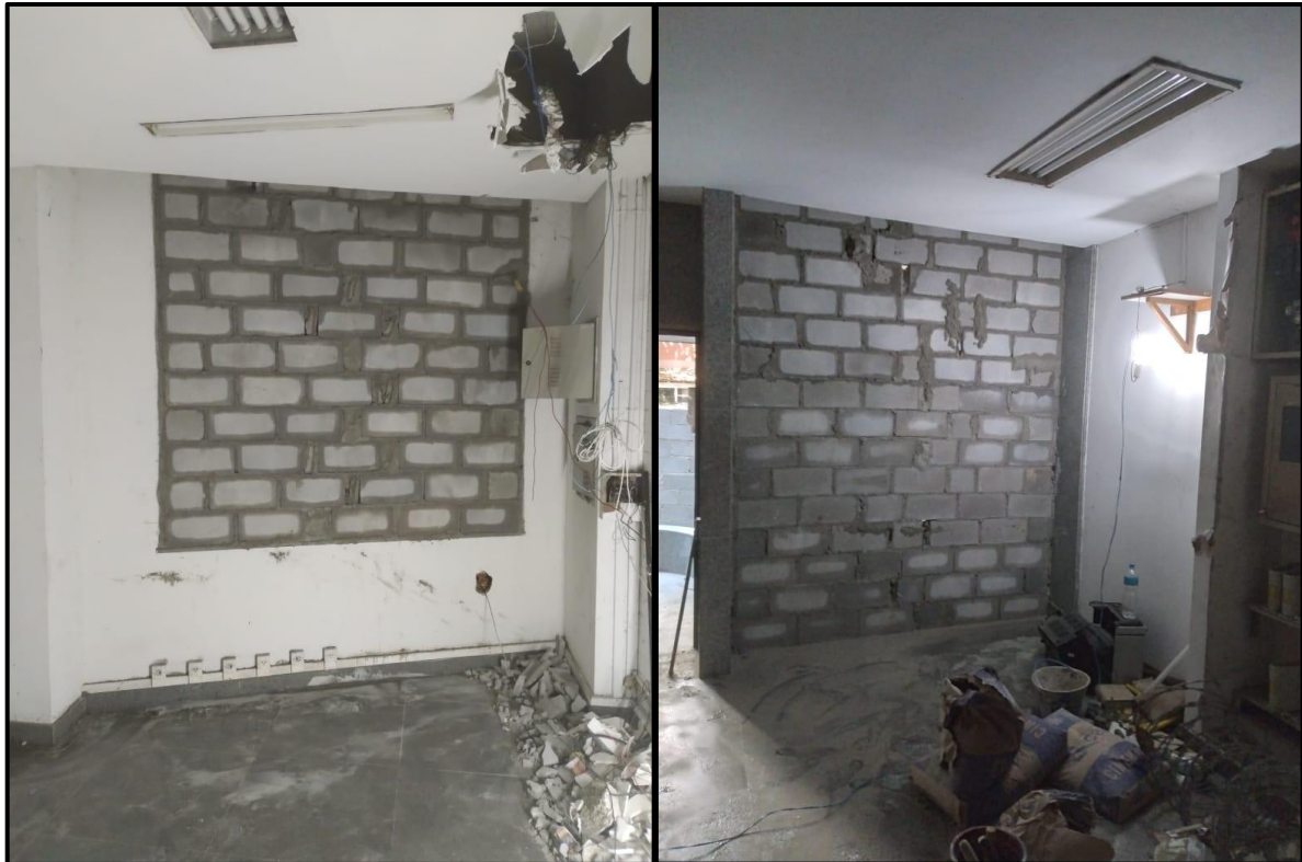
(Imagens das entradas sendo lacradas com blocos de concreto)
