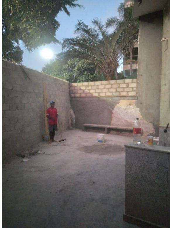
(Imagem que retrata o muro construído e um dos serventes da empresa contratada)
