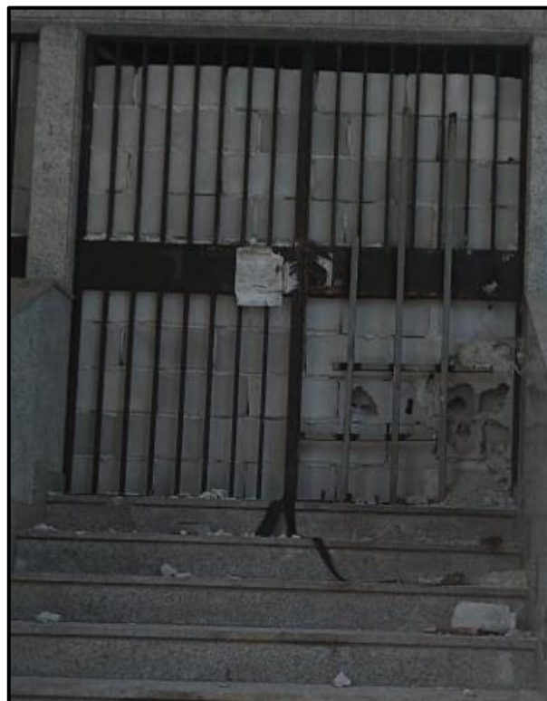
(Imagem que retrata a parede sendo aos poucos destruída no canto inferior direito)
